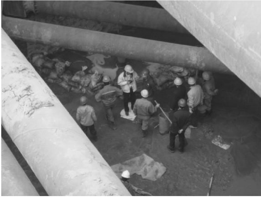
坑底堵漏情况
